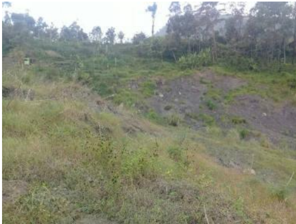
Gambar 5. Kerusakan akibat bencana tanah longsor tahun 2010.
