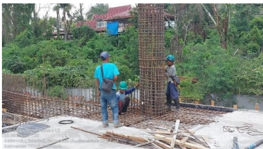
Gambar 2. Pemasangan tulangan kolom
