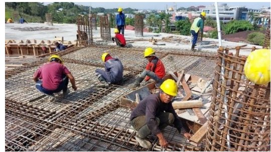
Gambar 3. Pemasangan tulangan pelat
