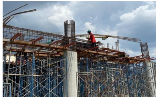
Gambar 1. Pemasangan tulangan balok
