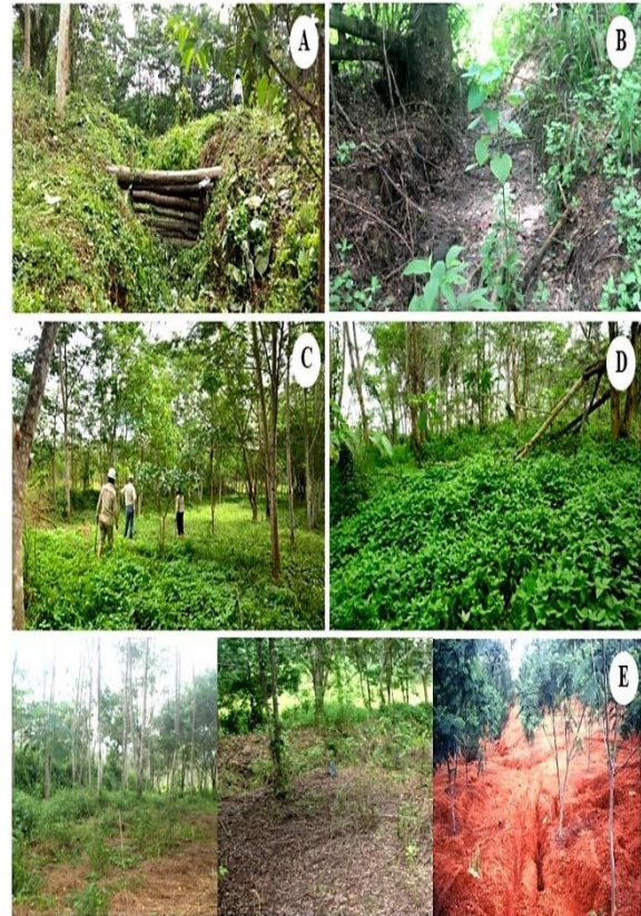
Gambar 3. Bangunan pengendali erosi-sedimentasi di IPDF1 (A), Paritan pengendali erosi-sedimentasi di OPDDM2 (B), Cover crops di Ex-Pit IPDC1 Komodo (C), Cover crops di IPDb Komodo (D), dan Kejadian erosi-sedimentasi di OPDDM2 dan IPDBM1 (E).
